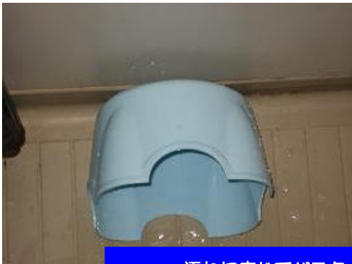
汚れに応じてバスター100を希釈し満遍なく塗布。しばらく放置しブラシなどでこすって洗浄。
